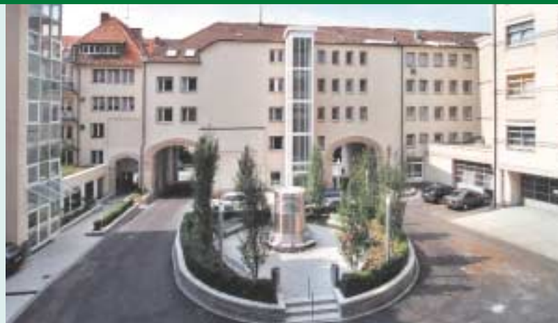
▲ Das Ambulanz-Zentrum an der Raphaelsklinik in den Räumen der ehemaligen Krankenpflegeschule
